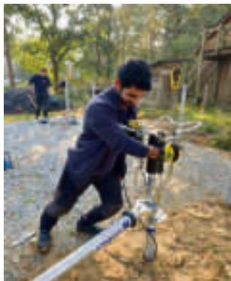
Die Schraubfundamente werden ins Erdreich gedreht.
